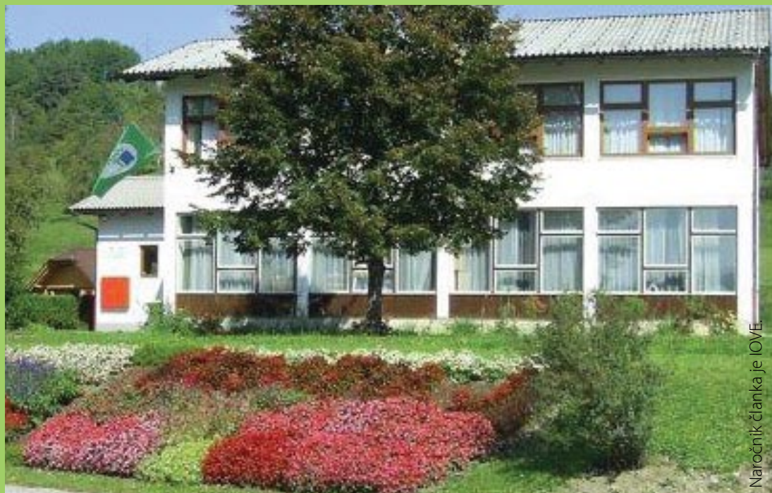
Osnovna šola Šentilj pri Velenju je že energetska obnovljena.
