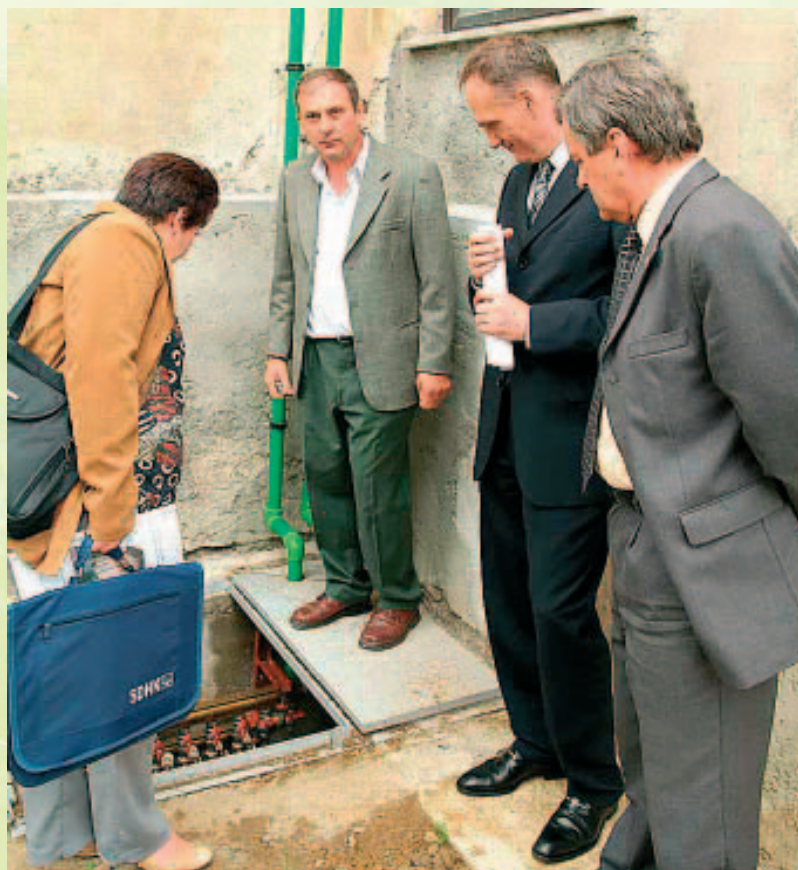
Cevi, ki so vgrajene v vrtnice, se zberejo v jašku. Od tu naprej sta speljani do toplotne črpalke in dve cevi.
