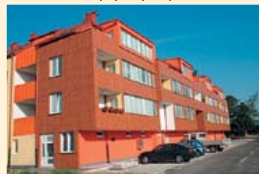
Nov poslovno stanovanjski objekt v Sp. Dupleku, v katerem je 13 neprofitnih najemnih stanovanj
